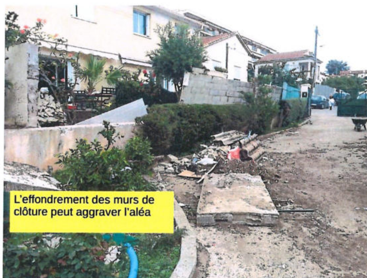
FIGURE 35 : EFFONDREMENT D'UN MUR SUITE À L'INONDATION
