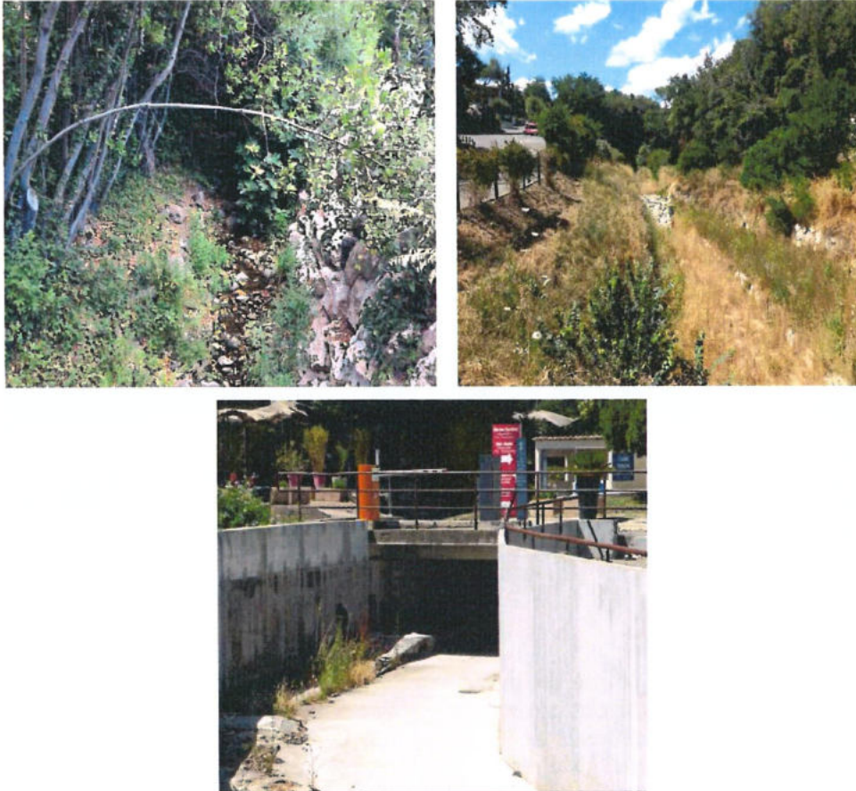
FIGURE 9 : LE VALLON DES COMBES AMONT, BASSIN DE RÉTENTION ET AU NIVEAU DE BIOT3000
