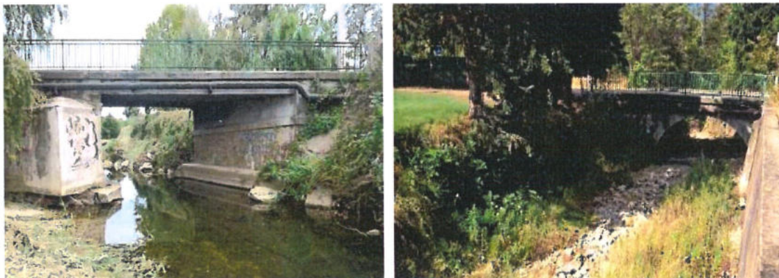
FIGURE 16 : PONT BREJNEV À GAUCHE ET PONT DU GOLF SUR LA VALMASQUE À DROITE
